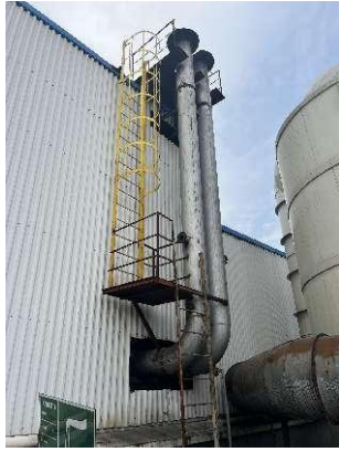
物料烘干废气排气筒
